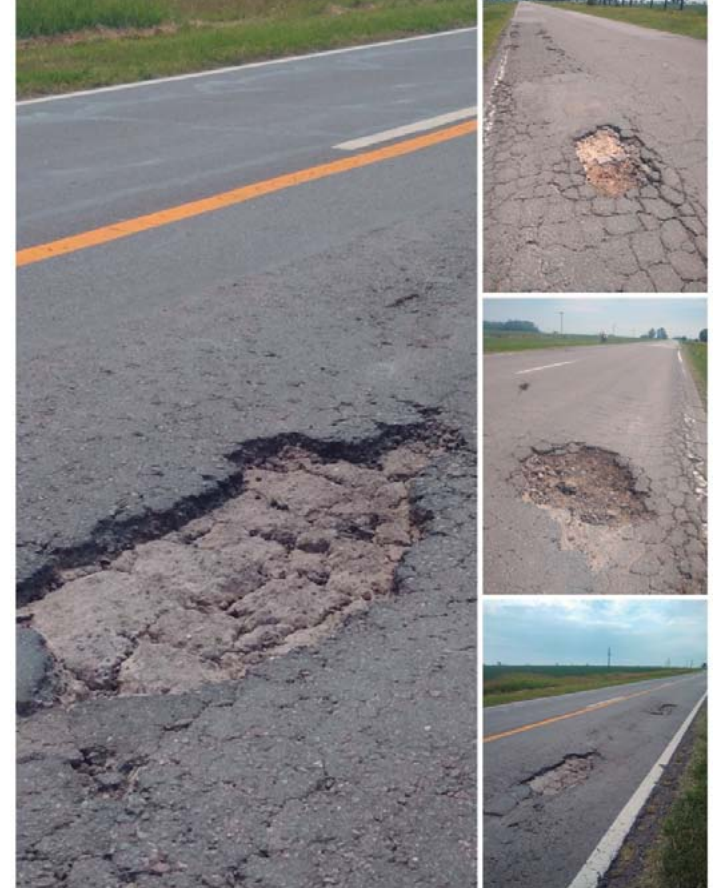
Estado actual de la traza asfáltica de la Ruta 15
